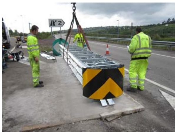
Rimuovere l'attenuatore e realizzare i fori O_1 e O_2
