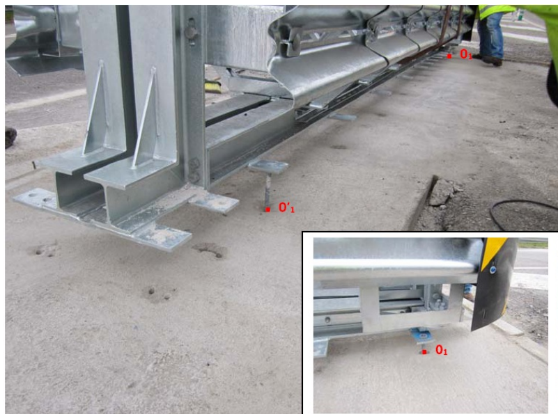
Posizionamento dell'assorbitore d'urto
