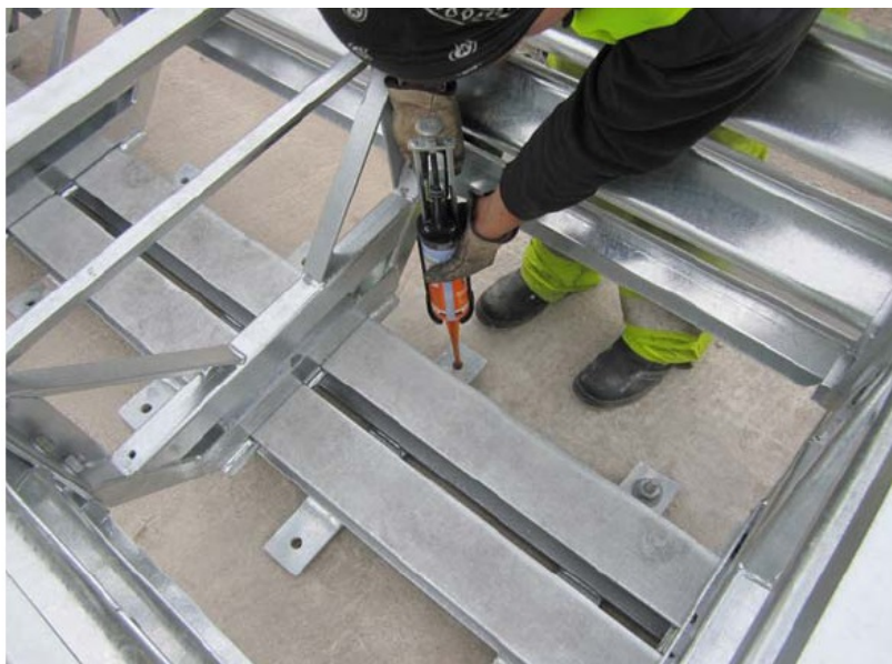
Inserimento della resina nei fori
