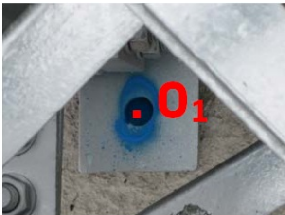
Marcatura dei punti di ancoraggio O_1 e O_2
