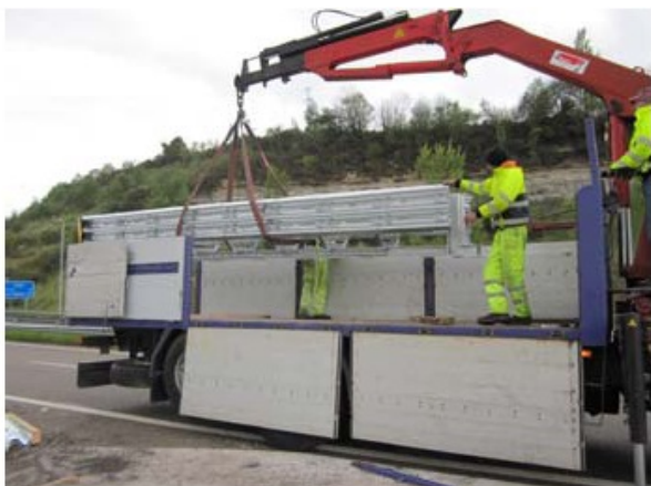
Scarico di un attenuatore d'urti AIR H110P
