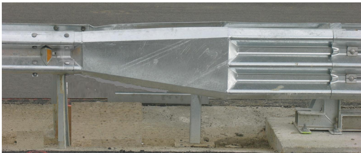
Transizione tra 3N e 2N – W-Beam, AIR H110/100/80/50P
